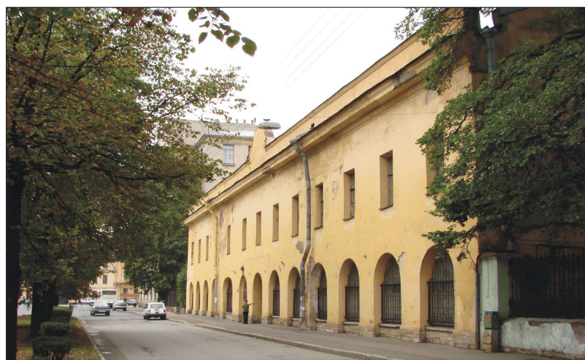
Общий вид лицевого фасада со стороны Тифлисской ул. Фото 2006 г.
