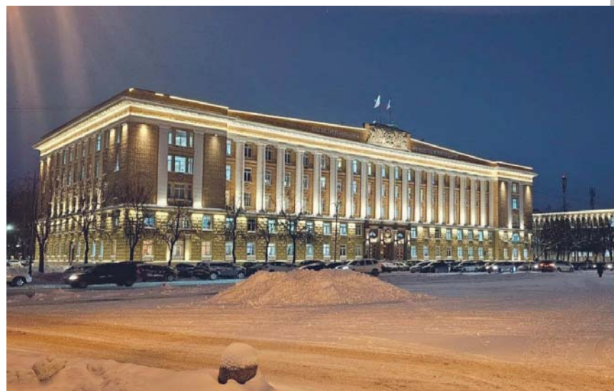
Капитальный ремонт системы архитектурной подсветки здания областной администрации (Россия, Новгородская область) ПАО «Ростелеком»
